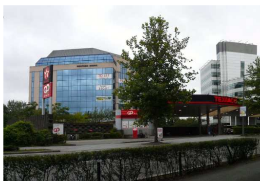
Figure 13 : Vue sur la station essence et les bâtiments de bureau ouest
