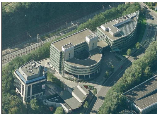
Figure 11 : Vue aérienne sur les immeubles de bureaux à l'ouest du site visé
